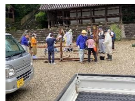
8/21 櫓解体 ご苦労様でした
